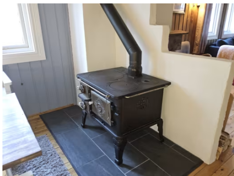
Bilde viser ovn på kjøkken.
