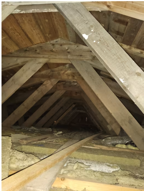
Bilde viser loft sett fra luke.
