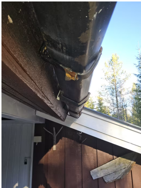
Bilde viser takrennekrok og takrenne.
