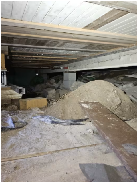
Bilde viser søylefundamentering og krypkrom.
