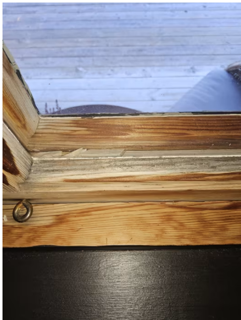
Bilde viser sprukne kittfalsler.
