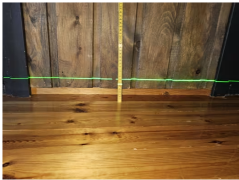
Bilde viser måling av etasjeskiller.
