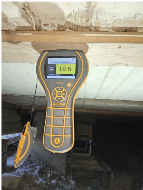
Bilde viser fuktmåling i kryprom.
