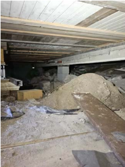
Bilde viser søylefundamentering og krypkrom.
