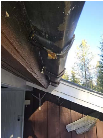
Bilde viser takrennekrok og takrenne.
