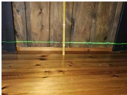
Bilde viser måling av etasjeskiller.
