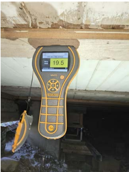
Bilde viser fuktmåling i kryprom.
