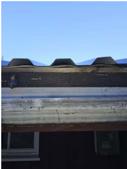
Bilde viser redusert lufting under takteking.
