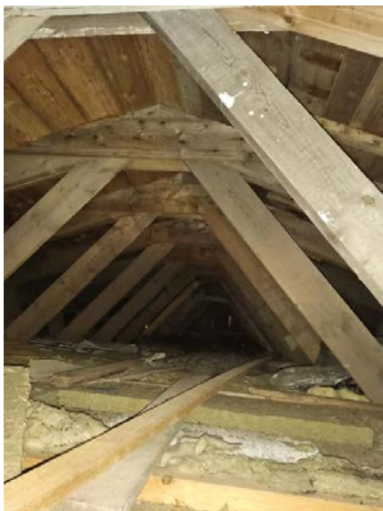
Bilde viser loft sett fra luke.
