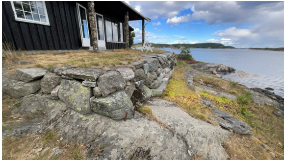
Forstøtningsmur i naturstein.
