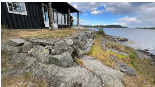
Forstøtningsmur i naturstein.
