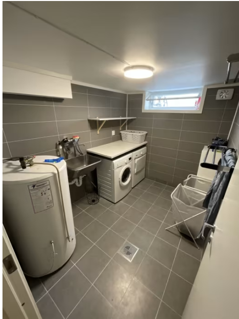
Viser vaskerom i kjeller.
