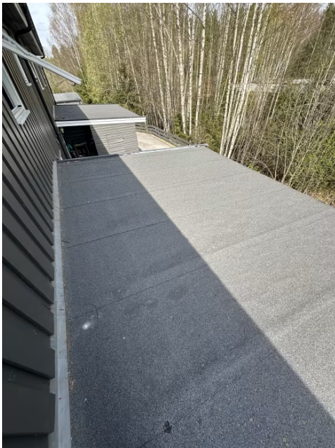
Viser takteking over inngangsparti/ bod.
