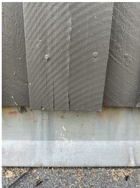
Det er værsliitt/oppsprukket trevirke/trepaneler.
