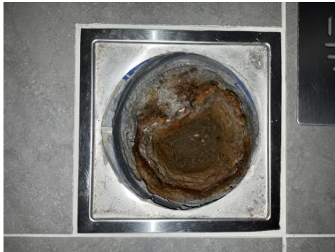
Viser sluk i gulv.
