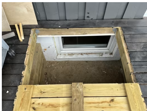
Rømningsvindu i kjeller, luke etablert på terrasse.
