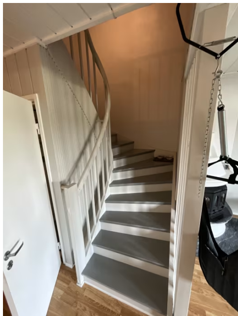
Viser innvendig trapp.
