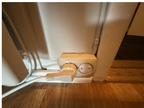
Anlegget har utidsmessige løsninger og ujordete stikkontakter.
