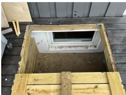
Rømningsvindu i kjeller, luke etablert på terrasse.
