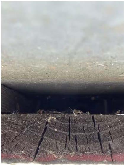
Det er ikke registrert bruk av musetetting mellom kledning og veggkonstruksjon.
