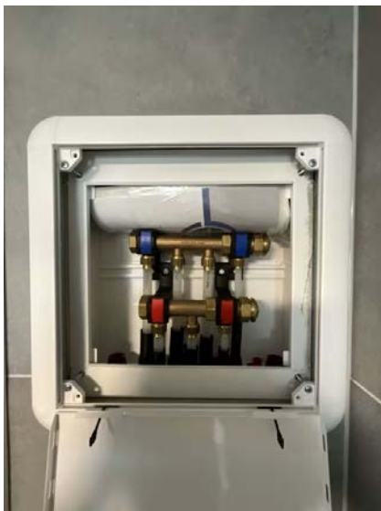
Vannrør med rør i rør system fra fordelerskap plassert på bad i 2.etasje og frem til sanitærinstallasjoner på bad.
