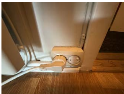
Anlegget har utidsmessige løsninger og ujordete stikkontakter.
