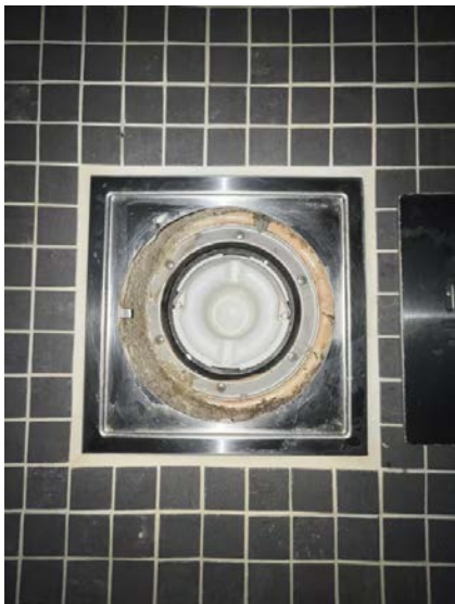
Viser sluk i dusjsonen.
