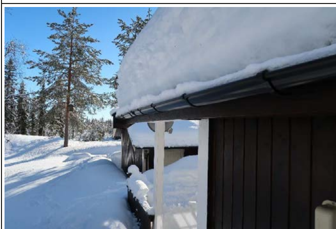
Bilde viser søyle med mindre justeringsbehov. Takrenne har motfall mot vindskie.
