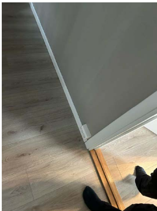
Skjema: "NELFO Per. kontr. Bolig NEK405-2" Spørsmål: Kontinuitet i jordledninger og utjevninger Filnavn: CF2DA652-12CA-4F0E-A5C5-FCE5F1666654.jpg
