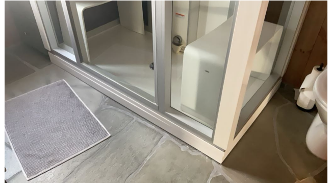
Begrenset inspeksjon av sluk
