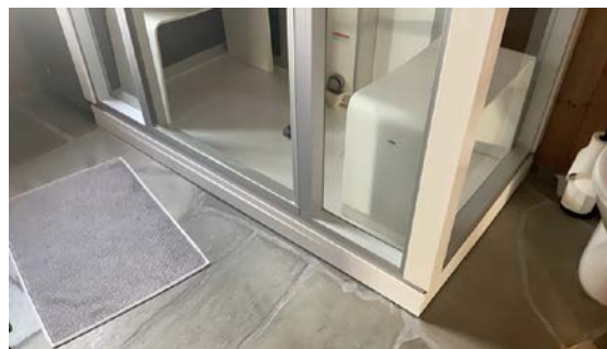
Begrenset inspeksjon av sluk
