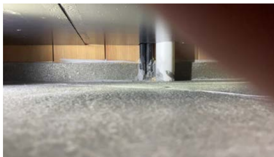
Ikke tilstrekkelig oppbrett av tettesjikt opp langs vegg, manglende bruk av slukmansjetter i overgang og sokkel montert på organisk materiale
