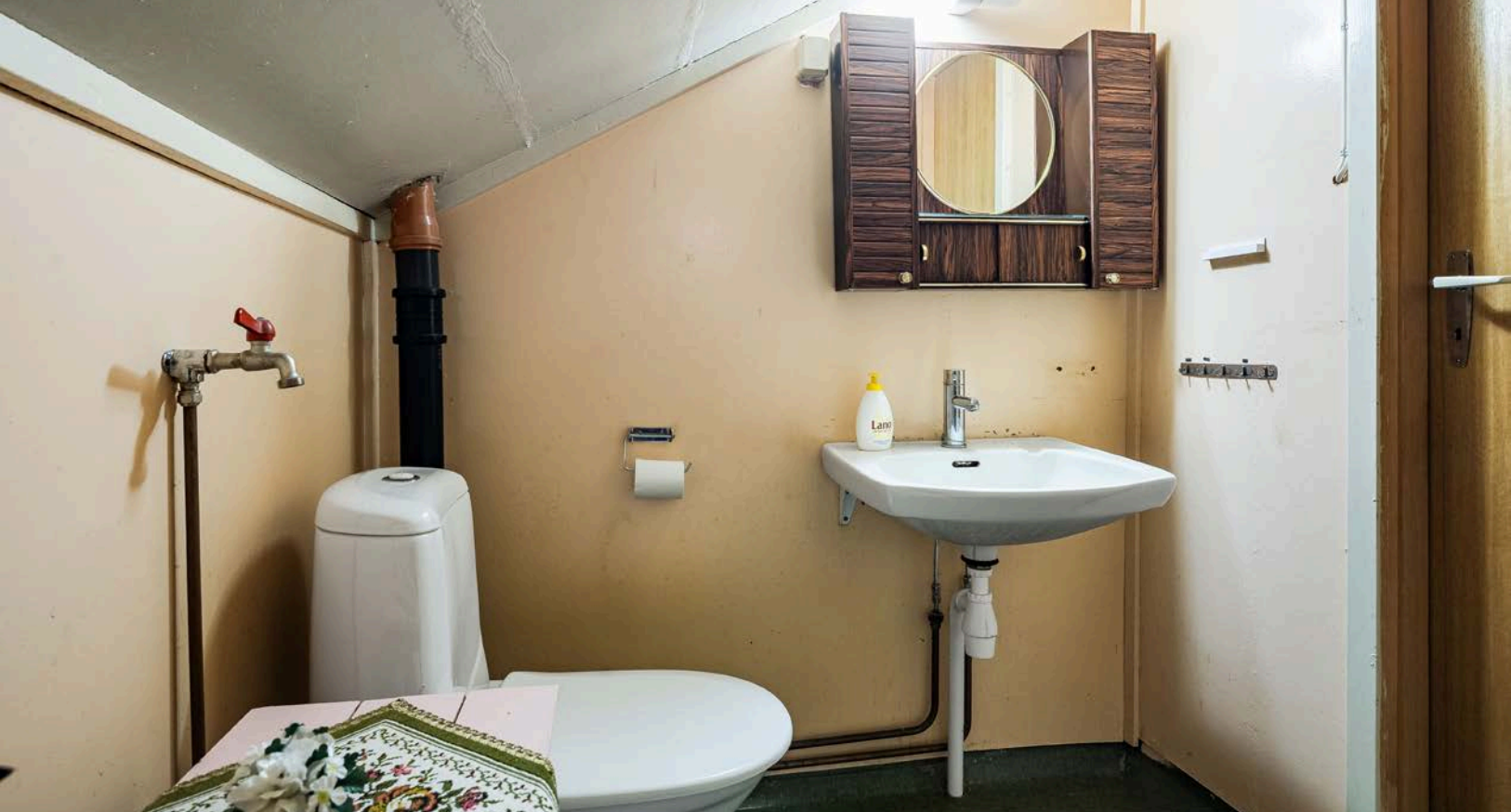
Eldre baderom med ukjent alder, opplyst fra tidlig 1970-tallet. Baderommet har ikke vært i bruk i senere tid og det påregnes oppgraderinger for å tilfredsstille dagens krav.
