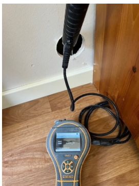
Fuktmåling i vegg mot våtsone.
