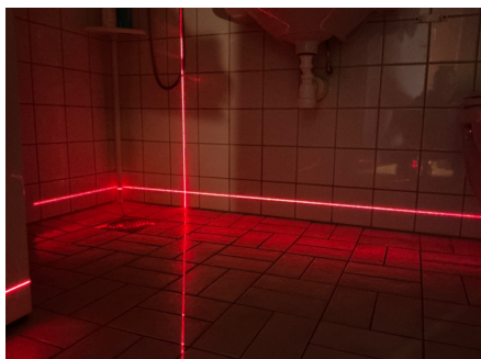
Fall på baderomsgulv er kontrollert med krysslaser.
