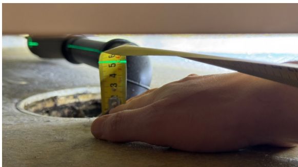
Kontroll av fallforhold.
