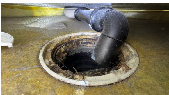
Kontroll av sluk.
