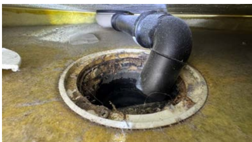
Kontroll av sluk.
