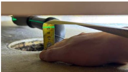
Kontroll av fallforhold.
