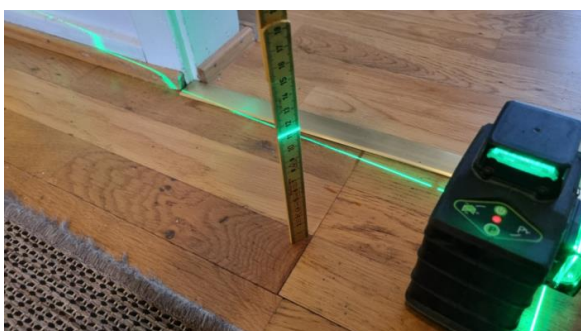
Kontroll av planavvik.
