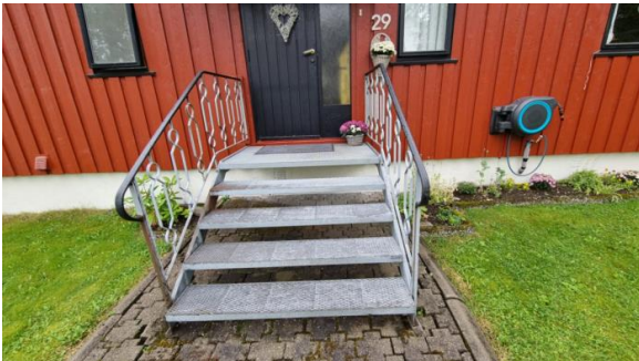
Trapp av strekkmetall.
