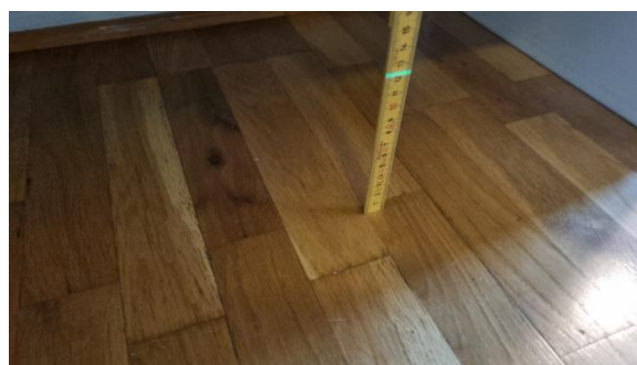
Kontroll av planavvik.
