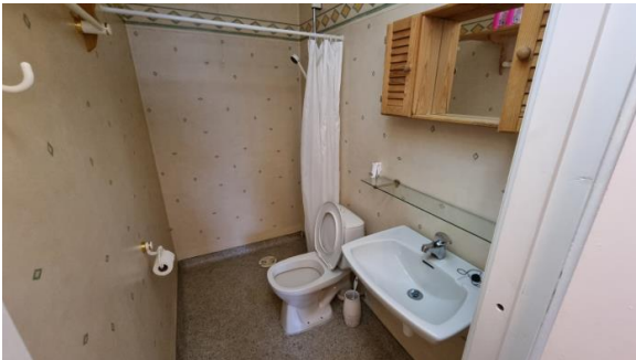
Oversiktsbilde av bad/wc i sokkeletasjen.
