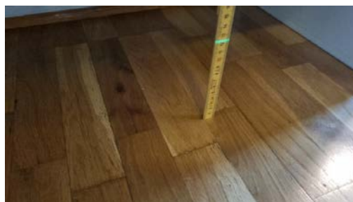
Kontroll av planavvik.
