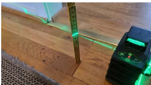
Kontroll av planavvik.
