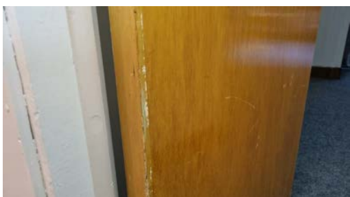
Dører er av eldre dato og har mindre bruksslitasje.
