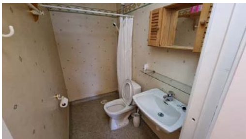
Oversiktsbilde av bad/wc i sokkeletasjen.
