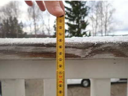
Rekkverkshøyde < 100 cm.
