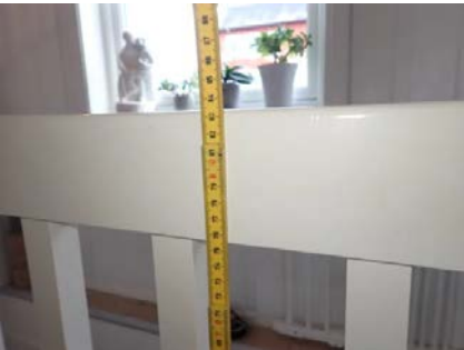
Rekkverkshøyde < 90 cm.
