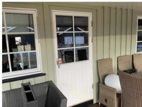
Balkongdør i 1. etasje.
