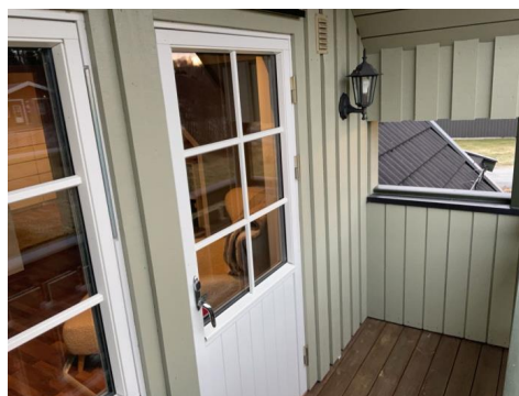
Balkongdør i 2 etasje.
