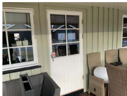
Balkongdør i 1. etasje.
