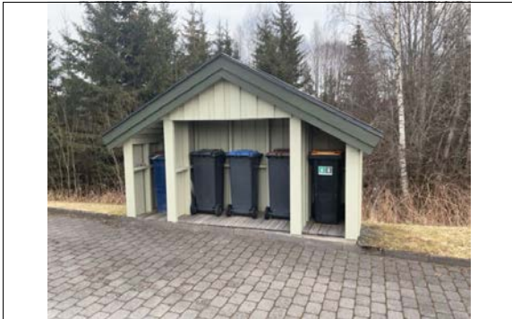
Frittstående skur for søppelcontainere.
