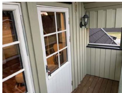
Balkongdør i 2 etasje.
