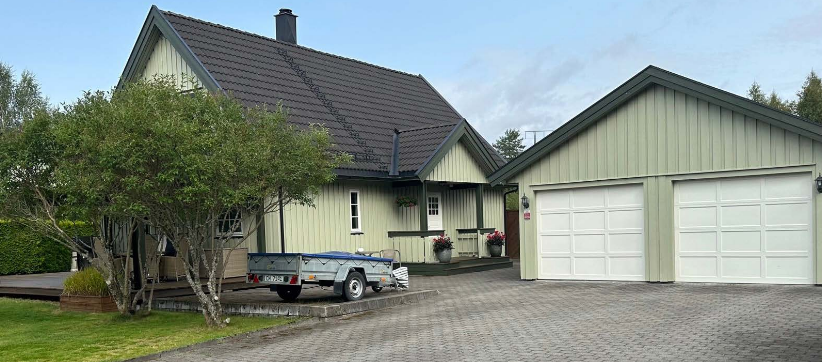
Dobbeltgarasje fra 2004 med elbil-lader og egen avskilt isolert bod, samt lagringshems på 24m 2 . (selgers private sommerbilde)
