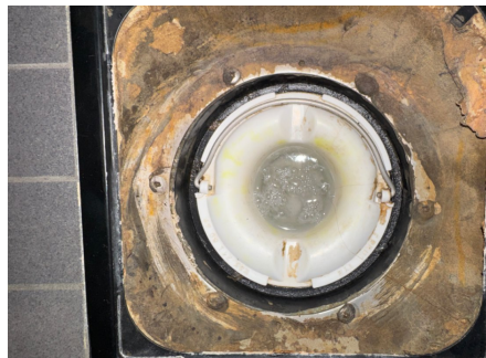
Plastsluk med klemring og synlig membran/mansjett
