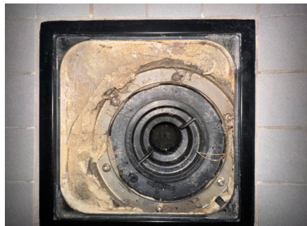
Plastsluk med klemring og synlig membran/mansjett
