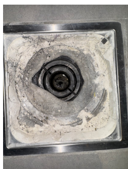
Plastsluk med klemring og synlig membran/mansjett
