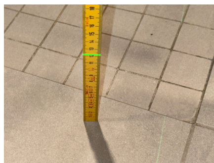
Fallforhold ca. 121 mm overkant gulv ved dusjsone
