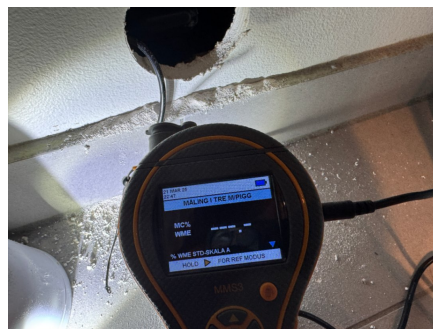
Hulltaking i teknisk rom/vaskerom
