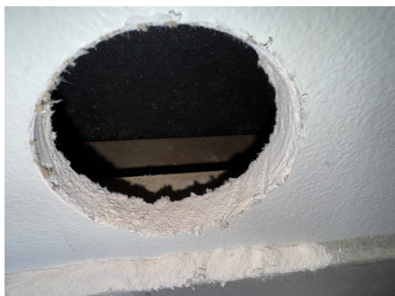
Hulltaking i teknisk rom/vaskerom
