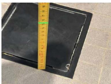
Fallforhold ca. 154 mm topp slukrist i dusjsone
