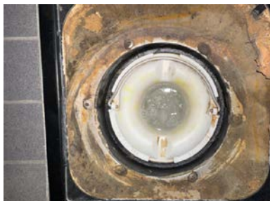
Plastsluk med klemring og synlig membran/mansjett
