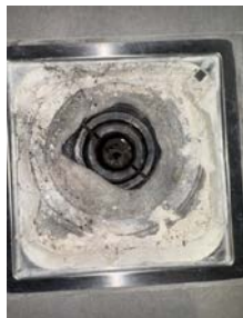
Plastsluk med klemring og synlig membran/mansjett
