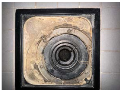
Plastsluk med klemring og synlig membran/mansjett
