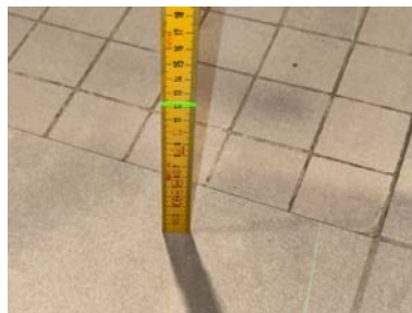
Fallforhold ca. 121 mm overkant gulv ved dusjsone
