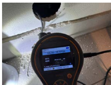
Hulltaking i teknisk rom/vaskerom
