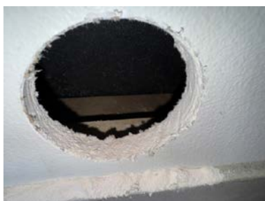
Hulltaking i teknisk rom/vaskerom
