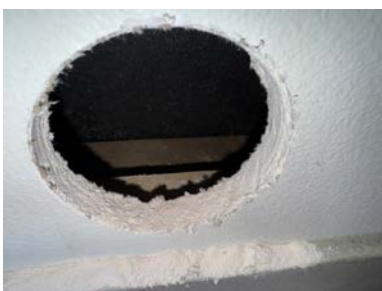
Hulltaking i teknisk rom/vaskerom
