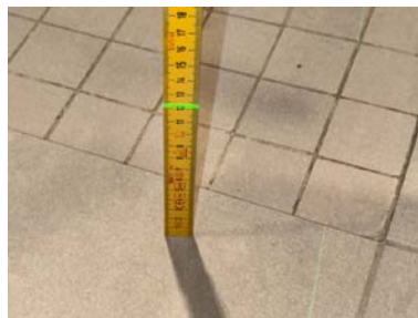
Fallforhold ca. 121 mm overkant gulv ved dusjsone
