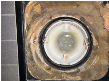
Plastsluk med klemring og synlig membran/mansjett
