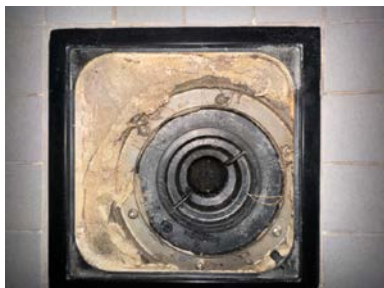
Plastsluk med klemring og synlig membran/mansjett
