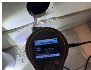
Hulltaking i teknisk rom/vaskerom
