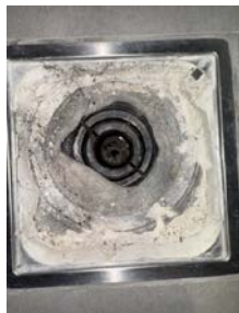
Plastsluk med klemring og synlig membran/mansjett
