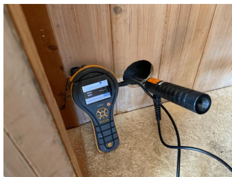
Fuktmåling i vegg
