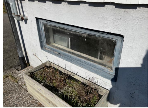
Kjellervindu fra byggeår.
