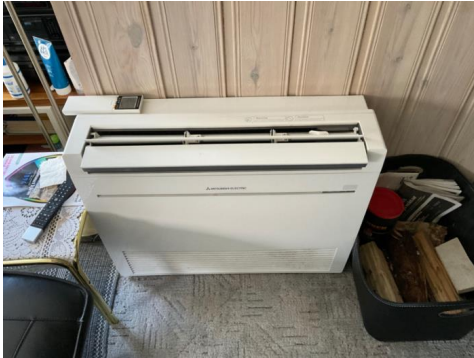
Luft til luft varmepumpe.
