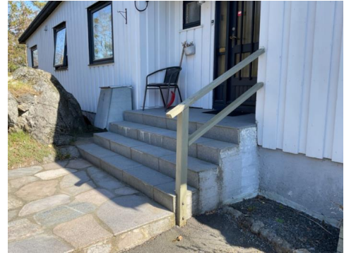
Betongtrapp i fbm. inngangsparti.
