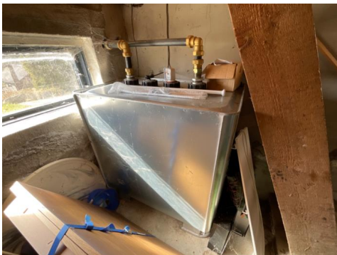
Innvendig oljetank.
