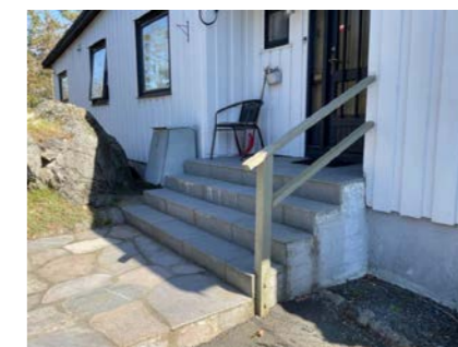
Betongtrapp i fbm. inngangsparti.
