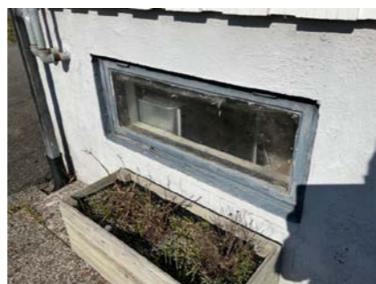
Kjellervindu fra byggeår.
