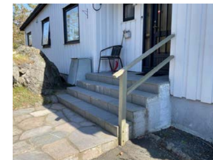
Betongtrapp i fbm. inngangsparti.
