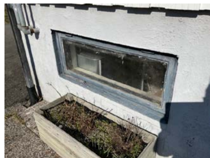
Kjellervindu fra byggeår.
