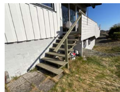
Plassbygget tretrapp fra terrasse.
