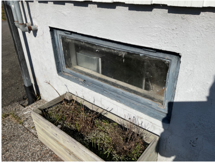
Kjellervindu fra byggeår.
