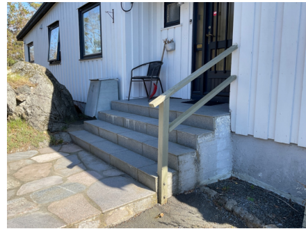
Betongtrapp i fbm. inngangsparti.
