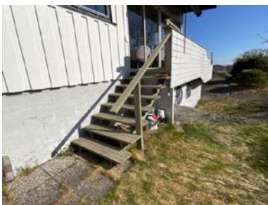
Plassbygget tretrapp fra terrasse.
