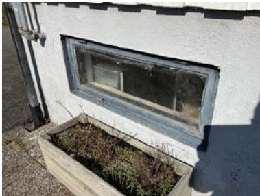
Kjellervindu fra byggeår.
