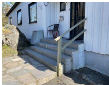
Betongtrapp i fbm. inngangsparti.
