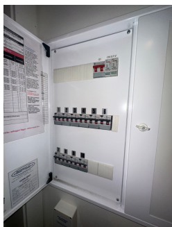
Sikringsskap med automatsikringer.
