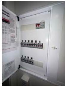
Sikringsskap med automatsikringer.
