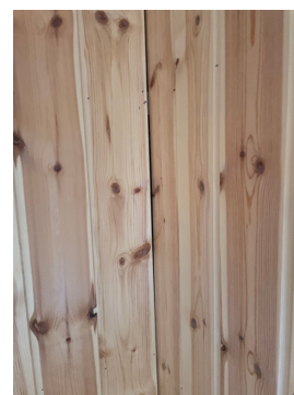
Ufaglig avslutning på trepanel i hjørner.
