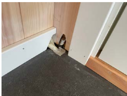
Eksempel på ufaglig avslutning/løsning.
