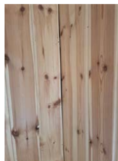
Ufaglig avslutning på trepanel i hjørner.
