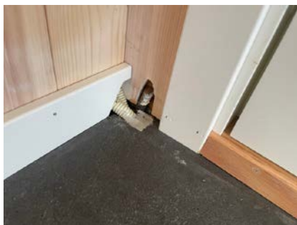
Eksempel på ufaglig avslutning/løsning.
