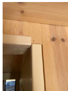
Eksempel på ufaglig avslutning på listverk
