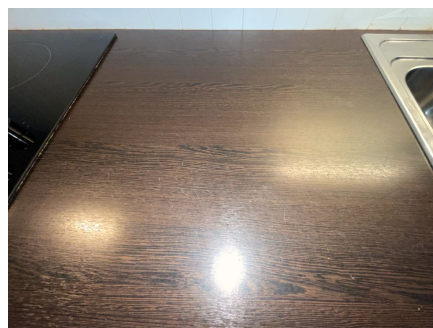
- Overflateslitasje på benkeplate
