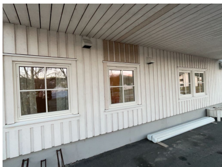
Vindu på soverom og stue/kjøkken
