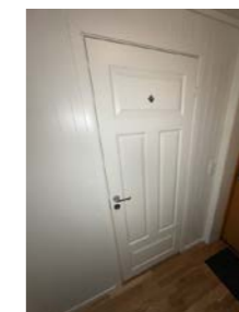
Dør til bad/vaskerom sett fra gang
