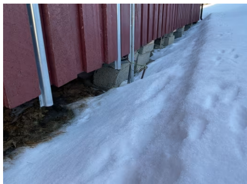
Fundamenter med utglidning.
