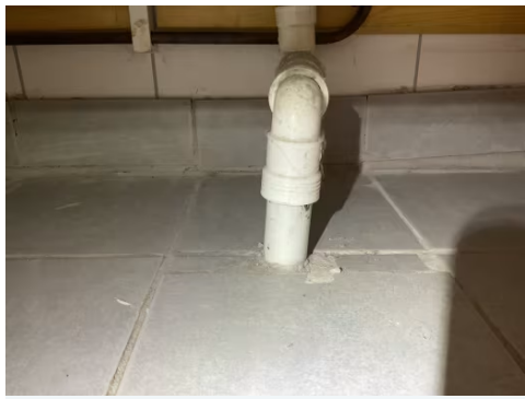
Rørgjennomføring i gulv.
