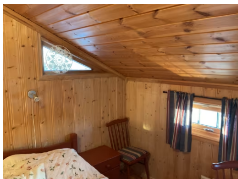
Vinduer på soverom ved bad.
