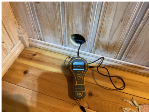
Hulltaking i tilstøtende rom.
