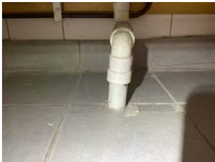
Rørgjennomføring i gulv.
