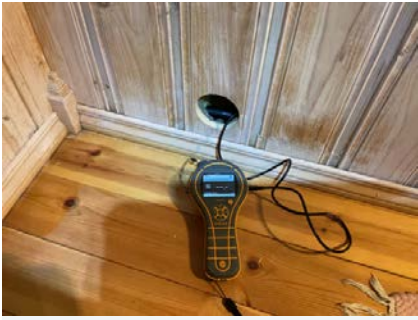
Hulltaking i tilstøtende rom.
