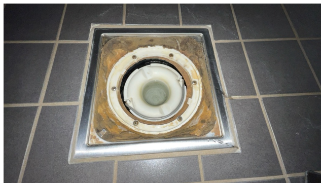
Kontroll av sluk.
