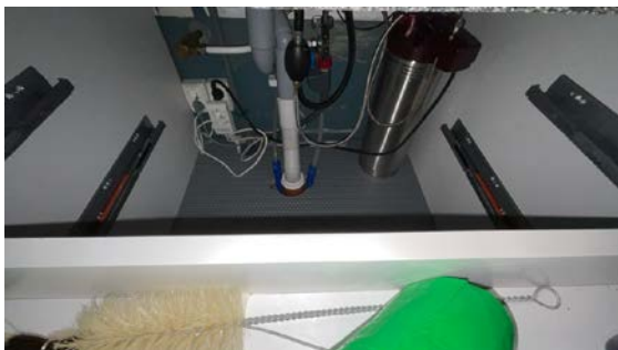
Besiktigelse av røropplegg.
