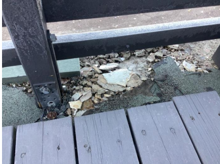
Eksempel på utett tekking.
