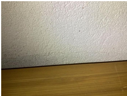
Innvendig horisontalriss.
