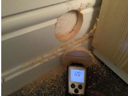
Hulltaking, og det måles tørt.
