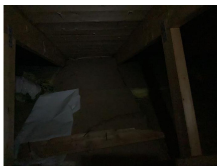
Luftespalte er stedvis stengt.
