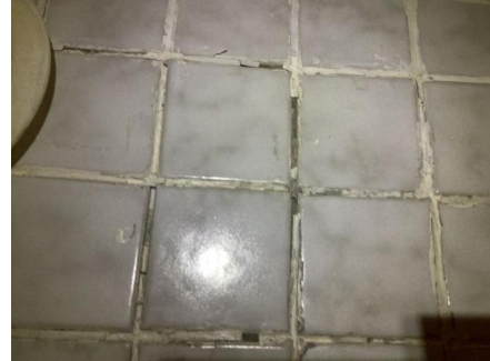
Riss- og manglende flisfuger.
