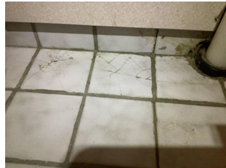
Riss- og manglende flisfuger.
