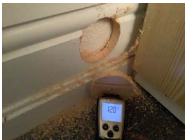
Hulltaking, og det måles tørt.
