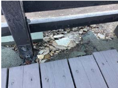
Eksempel på utett tekking.
