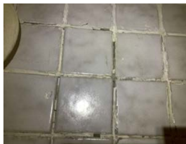
Riss- og manglende flisfuger.
