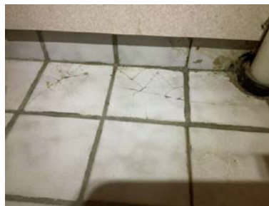
Riss- og manglende flisfuger.
