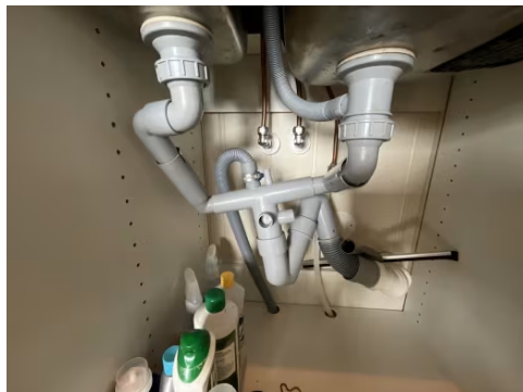
Viser vann og avløpsinstallasjoner under kum.
