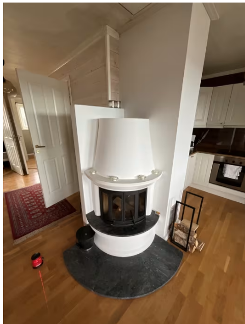
Viser ildsted plassert i stue
