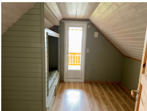
Hele takkonstruksjonen er gjenbygget.
