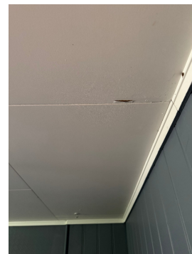
Noe skader og vridning i folierte takplater
