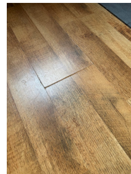
Oppsvulmet skjøt i laminatgulv.
