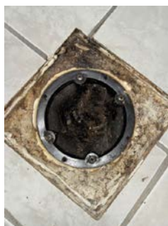
Det er påvist manglende membran/tettesjikt på våtrommet under servant.
