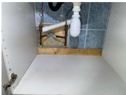
Det er påvist manglende membran/tettesjikt på våtrommet under servant.
