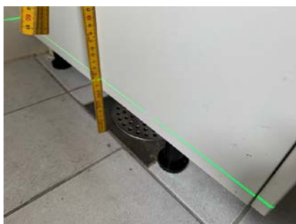
Målt høyde ved sluk 11 cm
