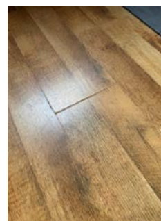
Oppsvulmet skjøt i laminatgulv.
