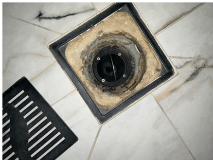
Mangler jording i sluk.
