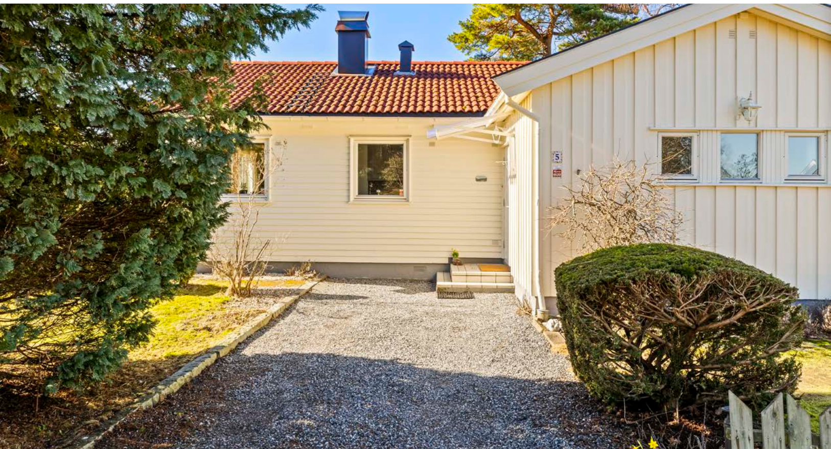
Ved inngangspartiet er det anlagt et praktisk gruslagt område som både fremhever adkomsten og gir en overgang mellom ute- og innerom.
