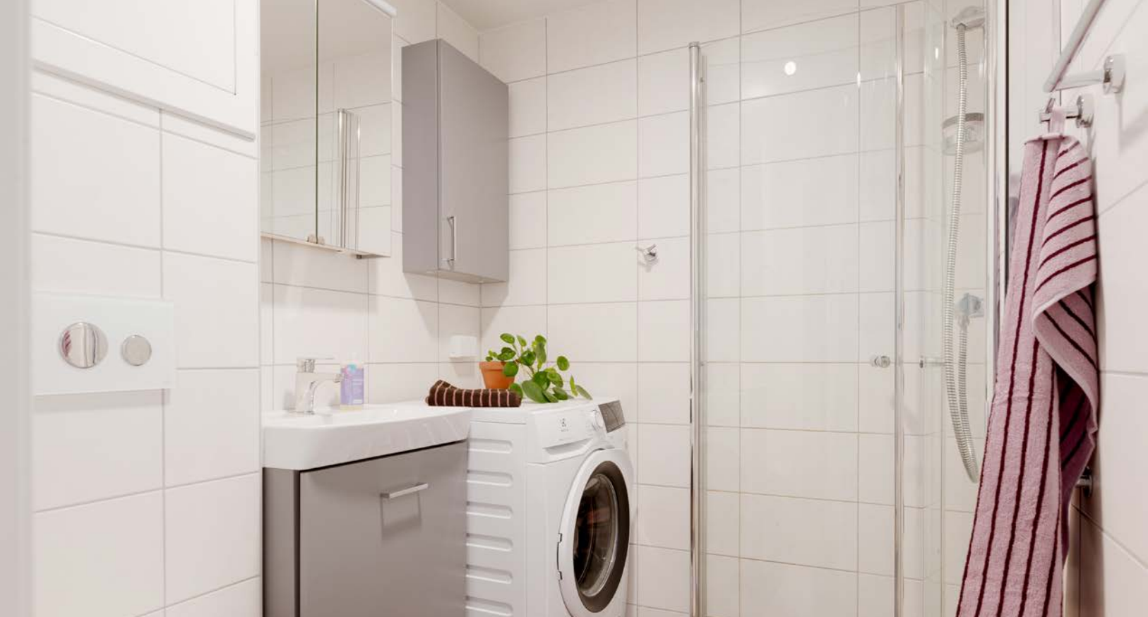
Badet er innredet med servant, vegghengt toalett, dusjhjørne med dører i herdet glass, samt opplegg for vaskemaskin.
