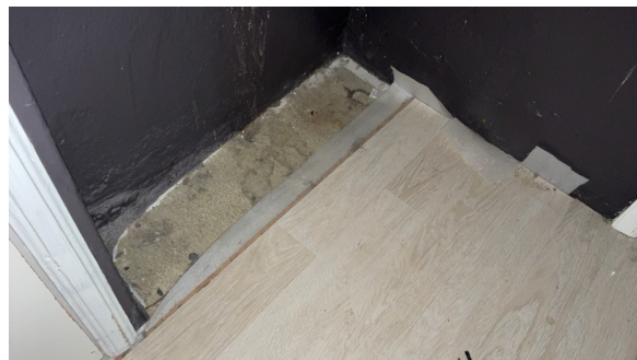
Enkel avslutning av gulv mot pipe i 2. etasje.
