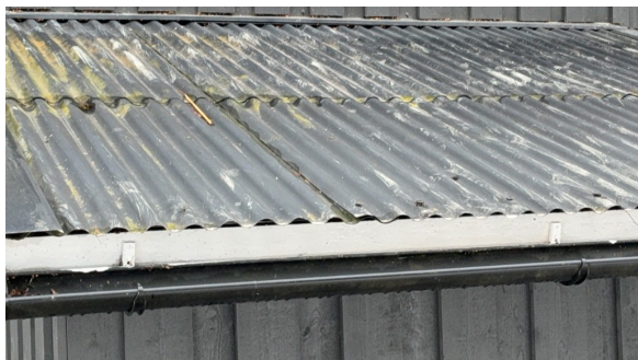
Eldre takplater av metall over teknisk rom.
