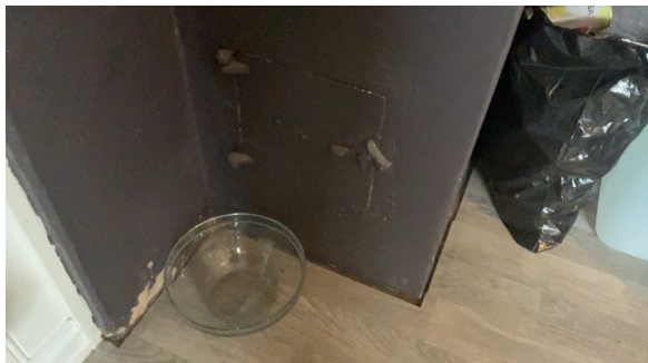
Sotluke på kjøkken.
