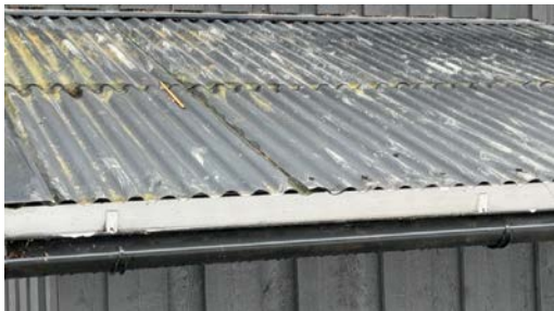
Eldre takplater av metall over teknisk rom.
