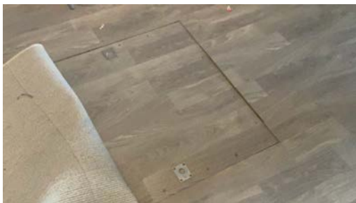
Grov tilpasning av luke i gulv på kjøkken.
