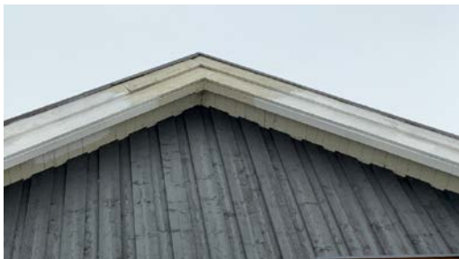
Eksempel på gjenværende malingsarbeid.
