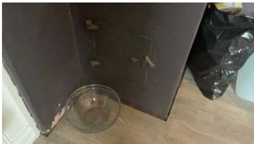
Sotluke på kjøkken.
