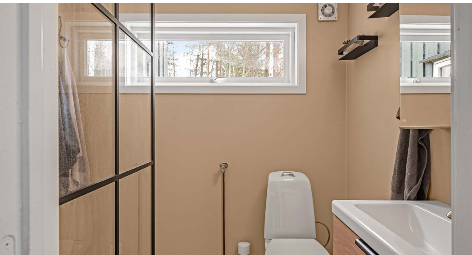
Overflatene på badet er pusset opp etter 2019. Her er det baderomsplater på veggene og belegg på gulvet med varmekabler.
